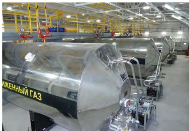
Рис. 2. Установка газового пожаротушения на базе четырех МИЖУ
