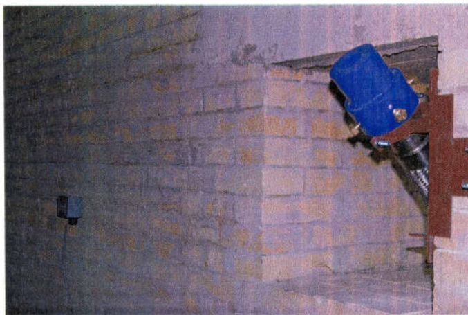
Рис. 2. Насадок распылитель Ду 43
